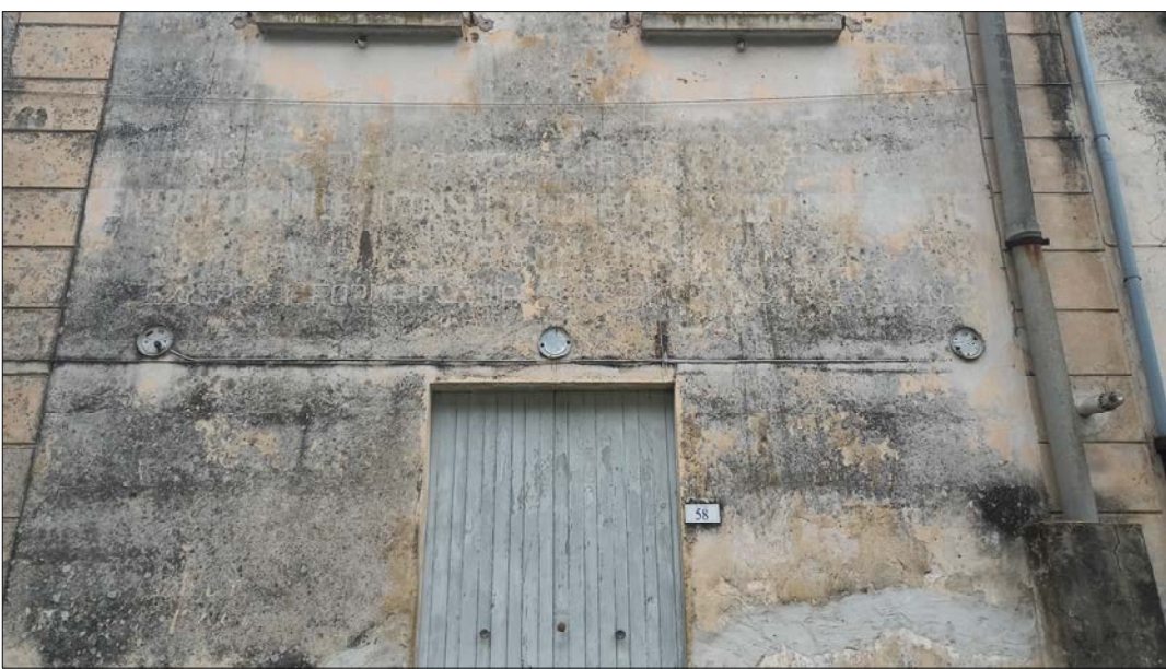
Dettaglio della scritta sul prospetto Nord afflitta da alterazione cromatica, macchie e patina biologica.
